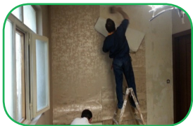
■ شکل ۲۴. استفاده از کاغذدیواری ضدامواج الکترومغناطیسی در فرایند ایمن‌سازی دیوارهای داخلی
