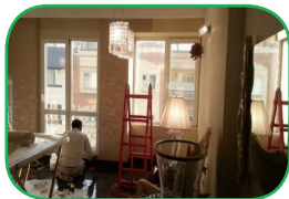
■ شکل ۲۴. استفاده از کاغذدیواری ضدامواج الکترومغناطیسی در فرایند ایمن‌سازی دیوارهای داخلی
