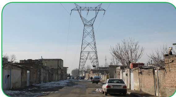
■ شکل ۸. ساخت منازل مسکونی در مجاورت خطوط توزیع برق
