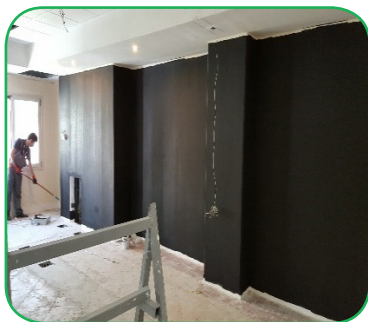
■ شکل ۲۳. استفاده از رنگ ضدامواج الکترومغناطیسی برای ایمن‌سازی دیوارهای داخلی ساختمان
