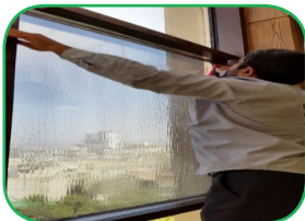
■ شکل ۲۲. اعمال برچسب شیشه ضد امواج به منظور ایمن سازی پنجره ها
